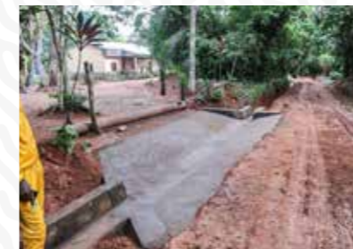
Canalisation des eaux de pluie et construction des entrées de résidences ©APDS
