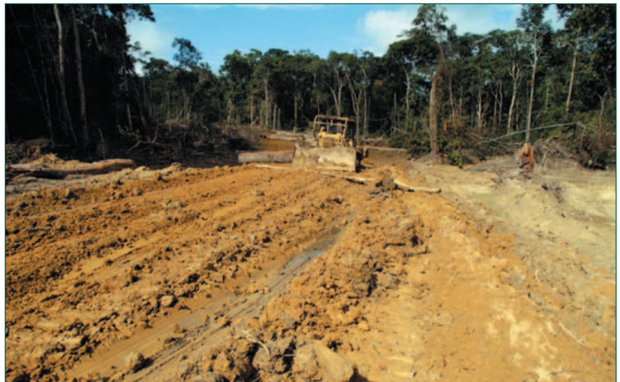
Figure 5.6. Une route en construction.
