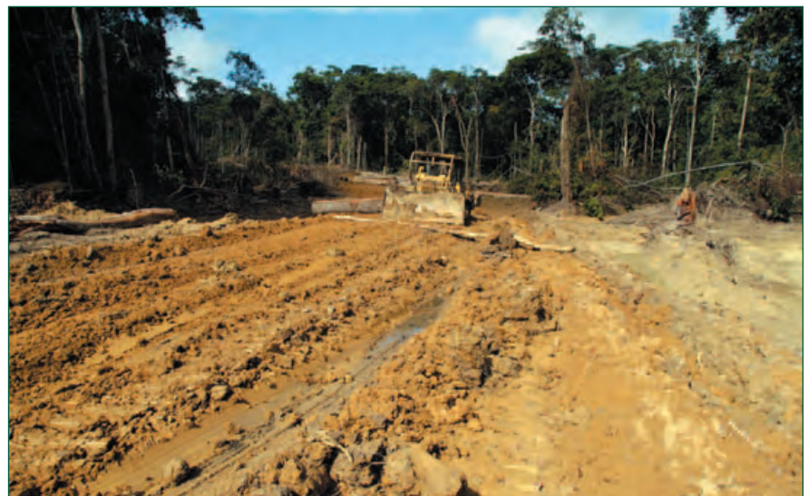
Figure 5.6. Une route en construction.
